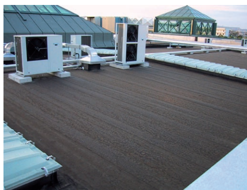
Installationer, der skal opsættes på taget, skal anbringes på beskyttelsesmatte
