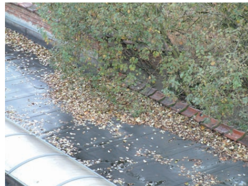
Vær opmærksom på blade og grene samt andet affald i tagrenden. Det kan føre til tilstopning af afløb og nedløbsrør.
